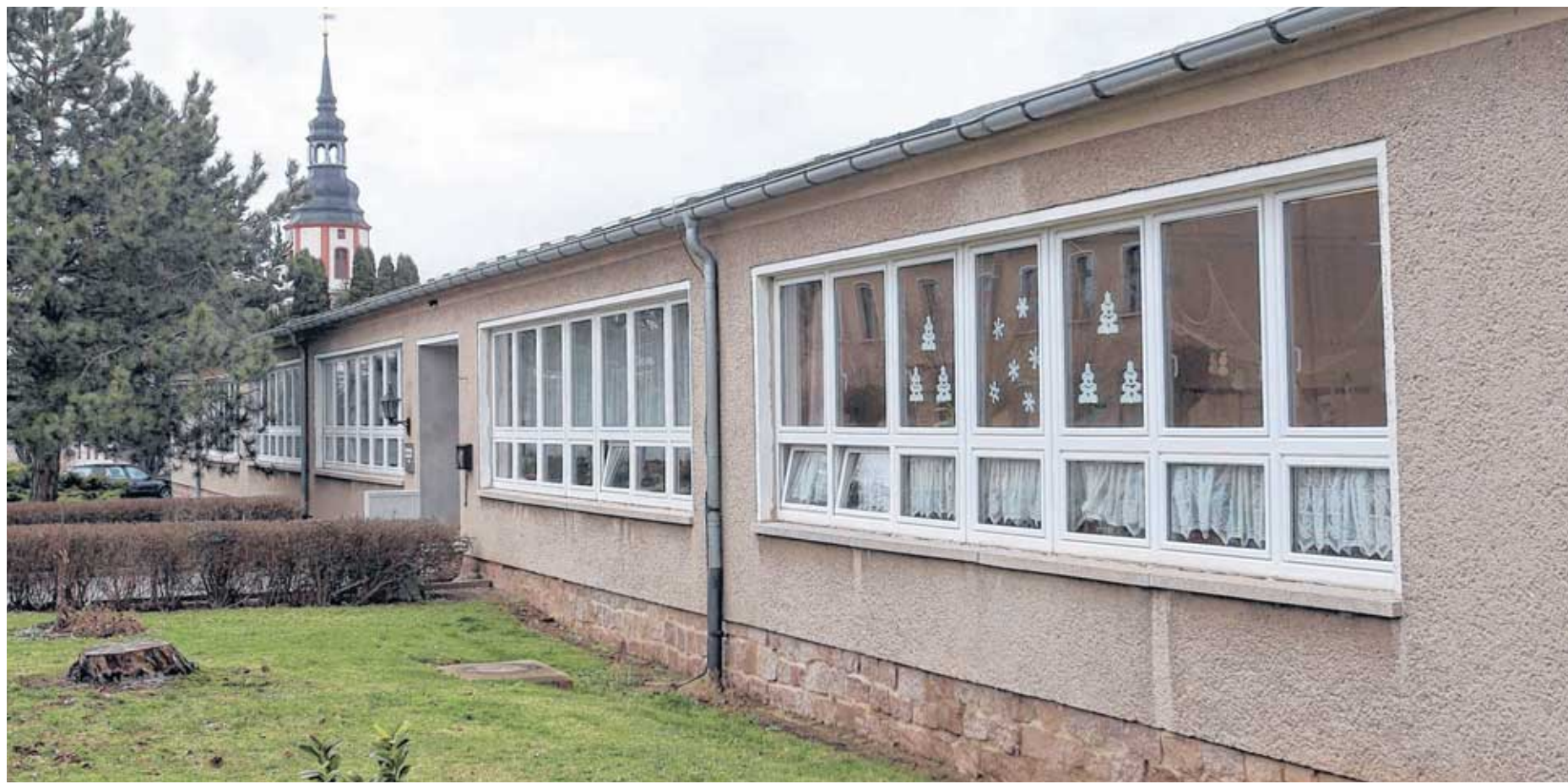
Seit rund 400 Jahren gibt es in Ponitz eine Schule, das heutige Schulgebäude stammt aus DDR-Zeiten.
